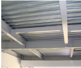
しっかりとした鉄骨で建物を支えます。
