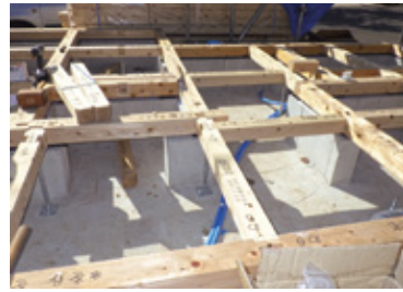
ここに断熱剤を隙間なく敷き詰めます。
